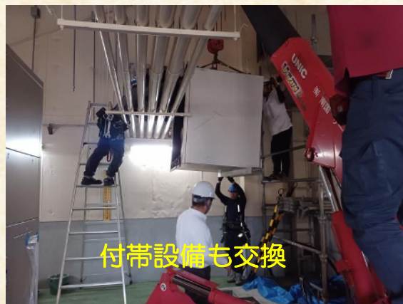
古い発電機の撤去・搬出
